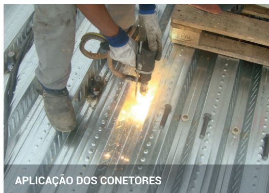
LAJE MISTA - COLABORANTE PC65® A BETONAR
